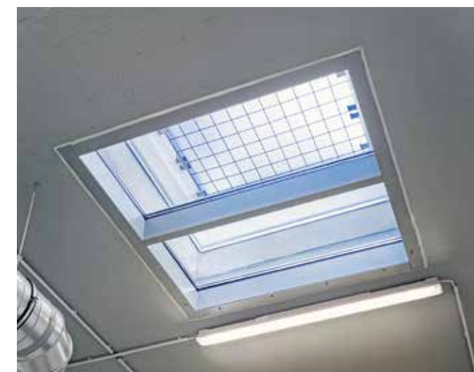
Witterungsschutz durch Lichtkuppel
