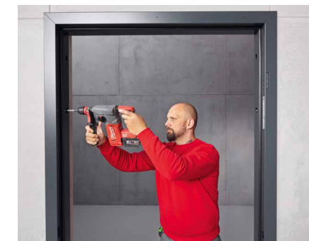
Bohrung durch die Öffnung der Montagebuchsen
