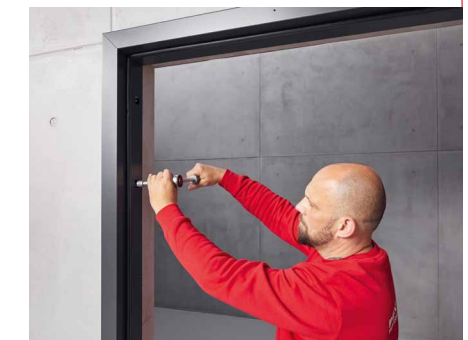
Fixierung der Dübelschraube
